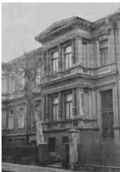
Рис. 120. Фото дома Кантора на Händelstrasse
